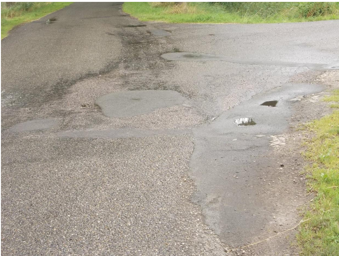
Foto 13: Reparaties van gaten en berm- en randschade
