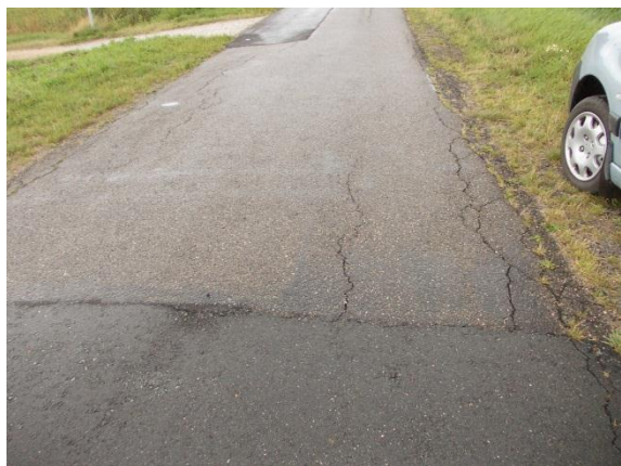
Foto 7: (plaatselijke) Reparaties aan een verharding
