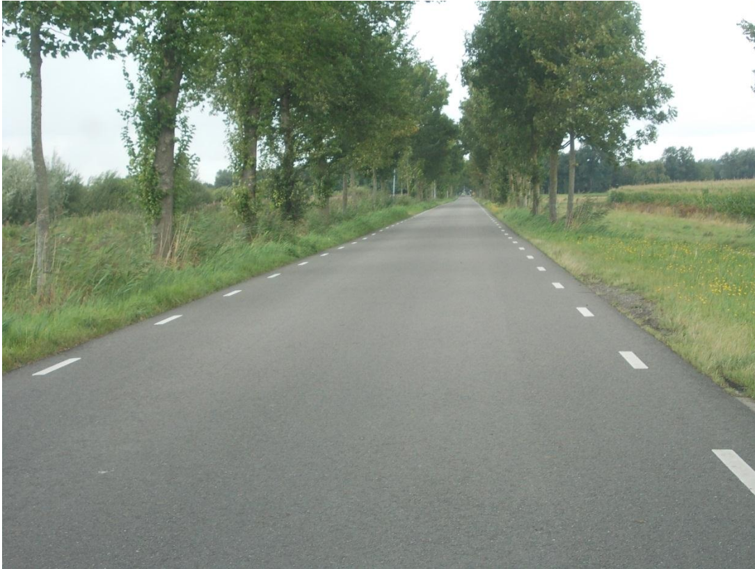
Foto 12: Ondanks dat de weg breed genoeg lijkt, toch enige schade aan de berm
