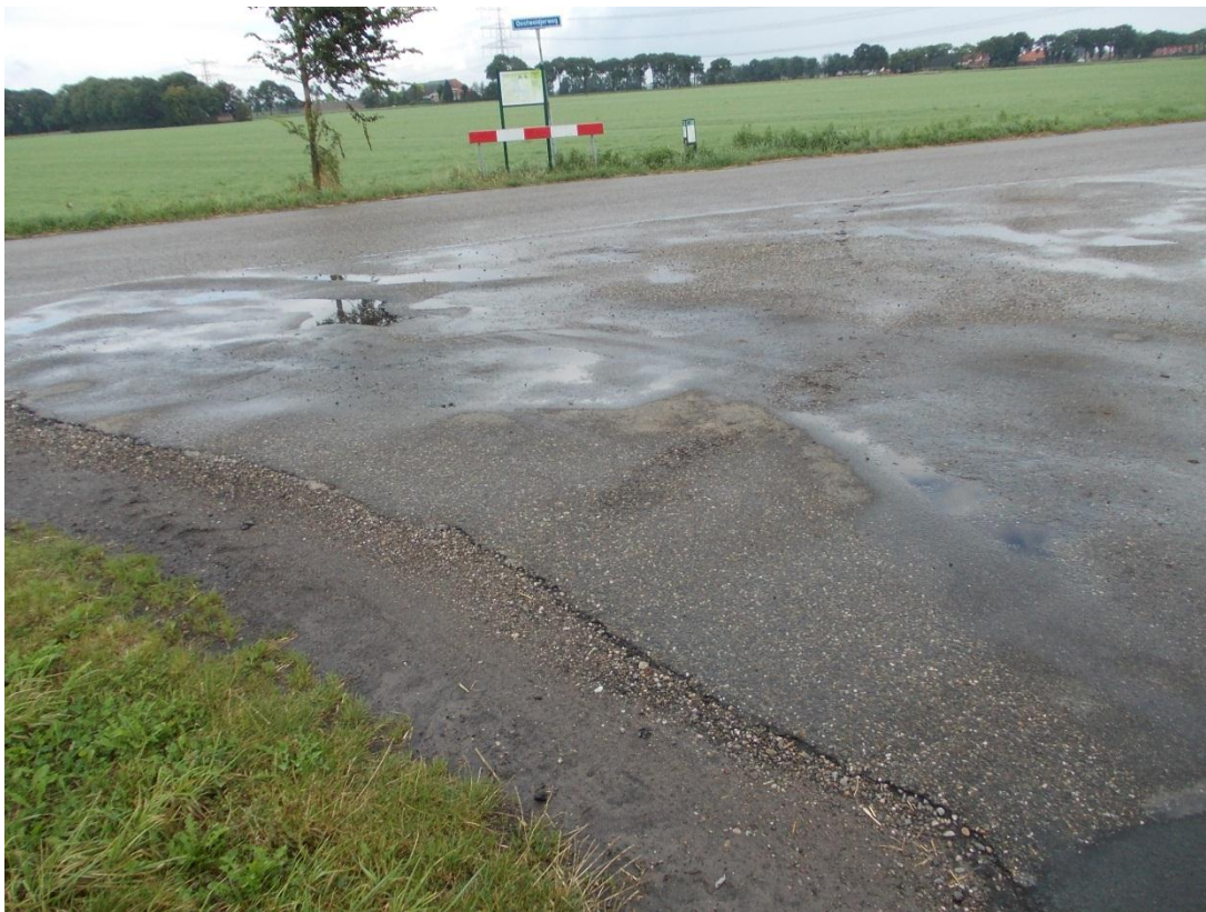
Foto 14: Reparaties van gaten, kapotgereden rand en berm
