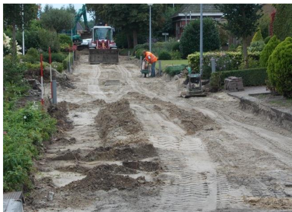
Foto 2: Vervanging volledige verhardingsconstructie (rehabilitatie)
