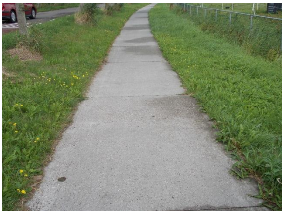
Foto 3: Fietspad van cementbeton
